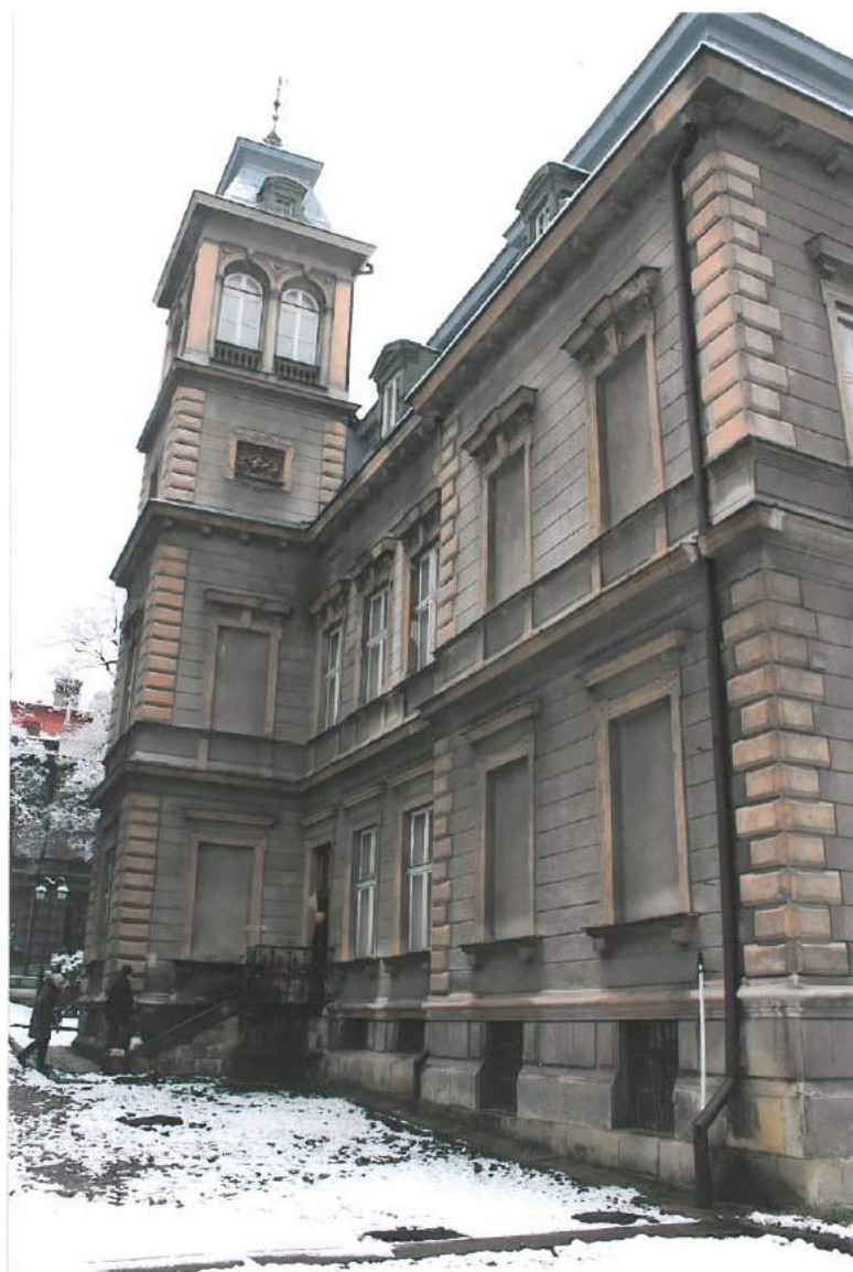
WILLA TEODORA SIXTA, BIELSKO-BIAŁA, 1883 R. Stan zachowania obiektu: elewacja południowa.
