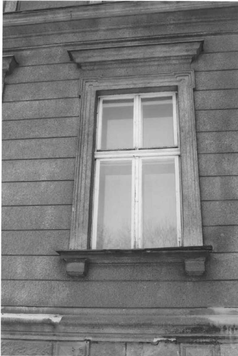
WILLA TEODORA SIXTA, BIELSKO-BIAŁA, 1883 R. Stan zachowania obiektu: elewacja wschodnia, okno.
