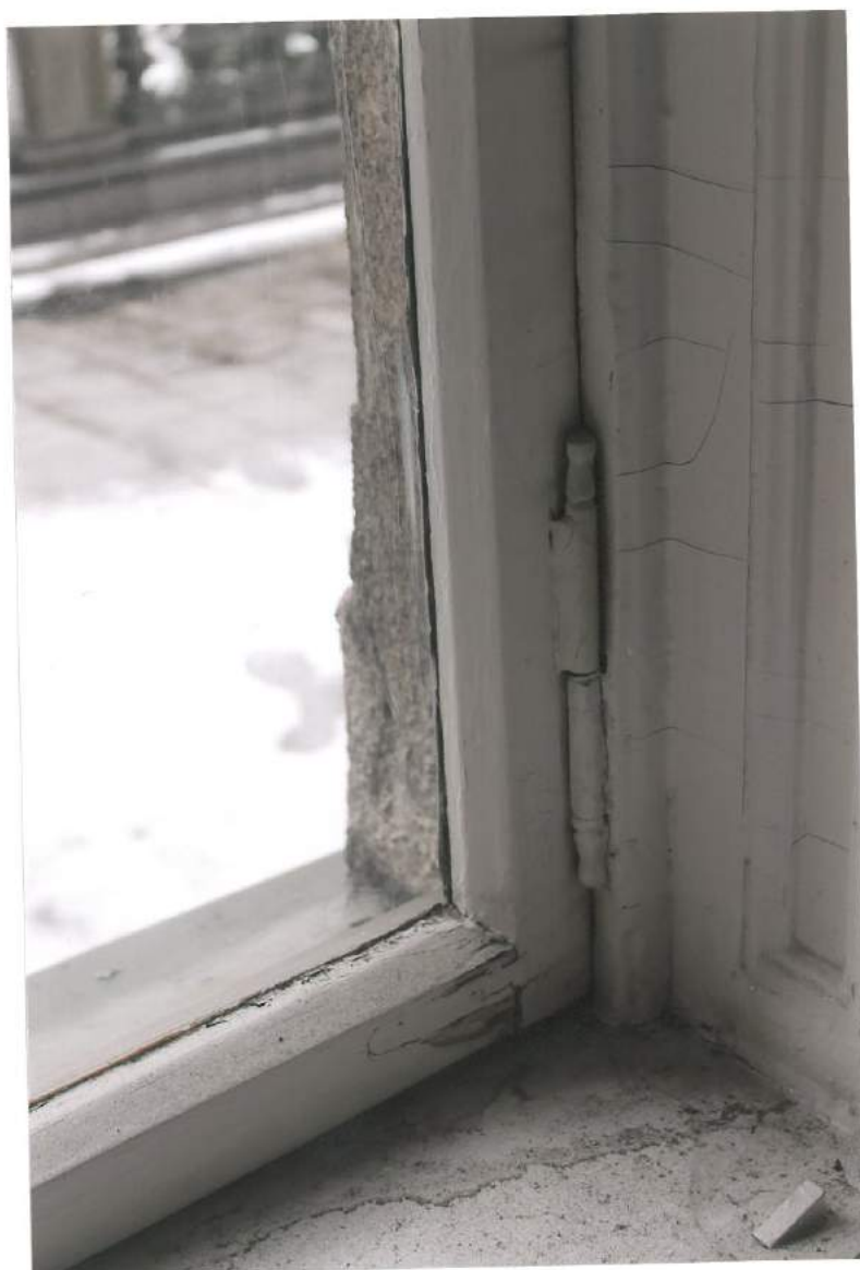
WILLA TEODORA SIXTA, BIELSKO-BIAŁA, 1883 R. Stan zachowania obiektu: elewacja zachodnia, piętro, okno skrzynkowe.
