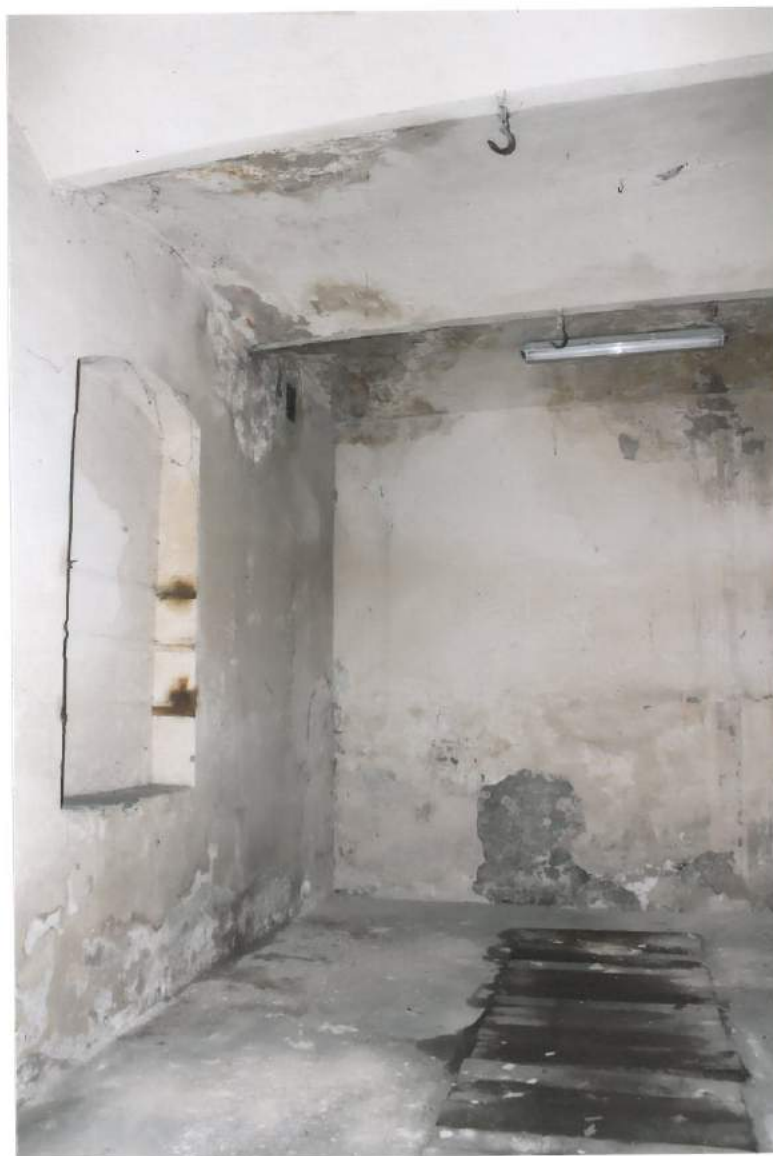
WILLA TEODORA SIXTA, BIELSKO-BIAŁA, 1883 R. Stan zachowania obiektu: wozownia, wnętrze.
